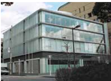
完成した新会館
