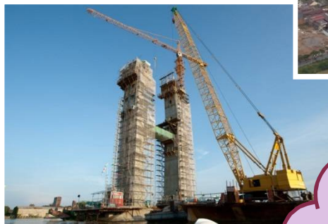
カンボジア、ネアックルン橋
