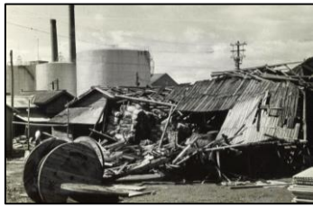
倒壊した倉庫
