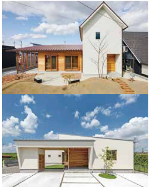
施工した新築住宅の一部
